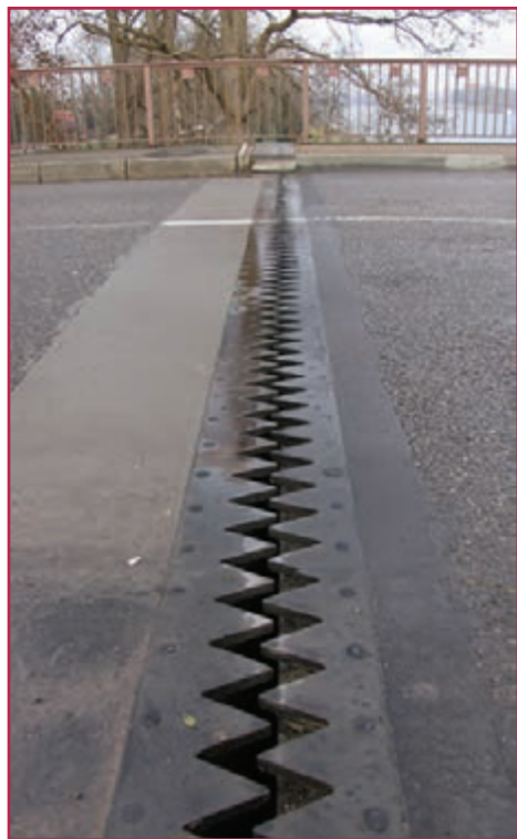
شکل ۲۳-۲. فاصله دندانه‌ای شکل بین دو قسمت پل
